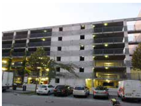
Parkhaus Helsinkistraße, gebaut als Gemeinschaftsgarage, seit Jahren halb leer
